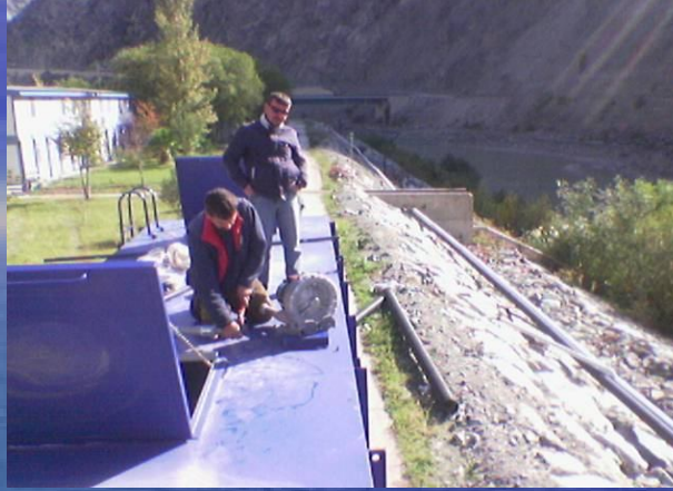
ERG İnşaat A.Ş. – Deriner Barajı ARTVİN
